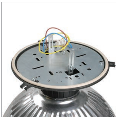
Шаг 1. Демонтаж балласта светильника
