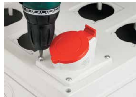
Монтаж розетки на 32 А
