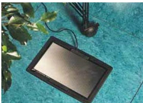
После подключения проводов и кабелей к электроустановочным изделиям закрепите каркас в лючке при помощи 2-х саморезов, поставляющихся в комплекте
