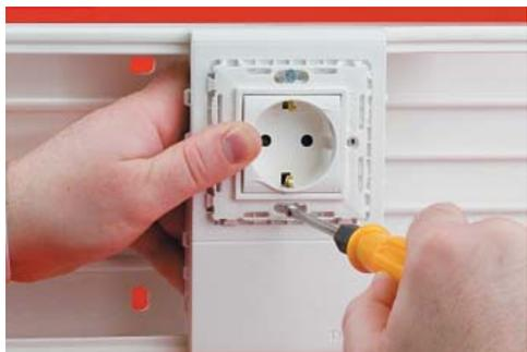
Электроизделие в каркасе (который обычно используется для скрытой установки ЭУИ в стены) с посадочным размером 60 мм зафиксируйте в рамке-суппорте при помощи 2-х шурупов-саморезов, поставляемых в комплекте с рамкой PDA-N
