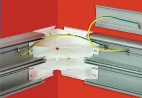
Проводом (код E0001BC) соедините основание одного из коробов с его крышкой. Одна из клемм зашелкивается на направляющую на дне короба. Рекомендуем установить её на расстоянии 16 см от клеммы провода (код E0001B). Вторая клемма провода (код E0001BC) зашелкивается на направляющую на внутренней стороне крышки.
