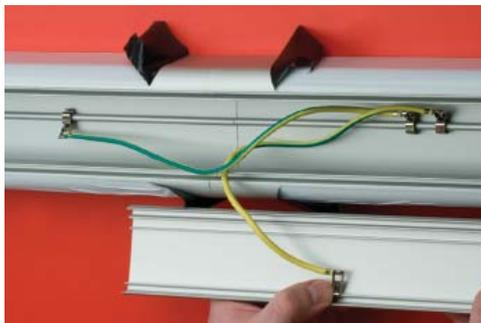
Провод (E0001BC) имеет 2 разные клеммы. Одну клемму защелкиванием установите на направляющую на дне короба (рекомендуем устанавливать эту клемму на расстоянии 16 мм от клеммы провода (E0001B) в сторону от стыка коробов).
