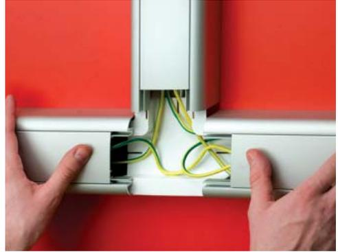
Защёлкиванием установите крышки на основания коробов, отступив от края (торца) каждого короба по 3 см.
