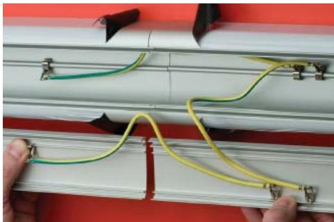
Проводом (код E0001C) соедините крышки стыкуемых коробов. Защёлкиванием установите клеммы провода (код E0001C) на направляющие, расположенные на внутренних сторонах крышек.
