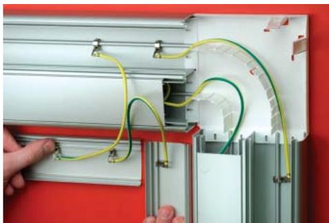
Проводом (код E0001BC) соедините основание одного из коробов с его крышкой. Одна клемма защелкивается на дне короба на расстоянии 16 см от клеммы провода (код E0001B). Вторая клемма (код E0001BC) защелкивается на направляющую крышки. Затем проводом (код E0001C) соедините крышки разных коробов.
