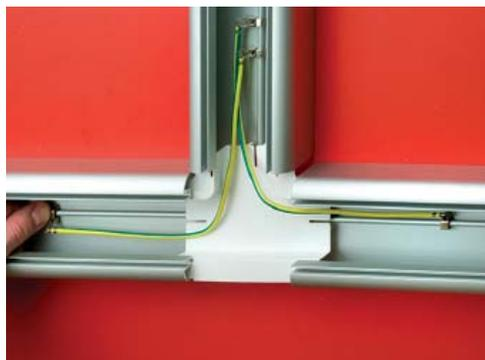
С помощью 2-х проводов заземления (код E0001B) соедините все основания алюминиевых коробов. Клеммы установите защелкиванием на направляющие на дне оснований коробов.
