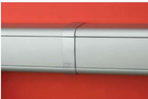
Рекомендуем полностью снимать защитную плёнку с коробов и крышек после завершения всех основных работ, чтобы сохранить презентабельный вид трассы.
