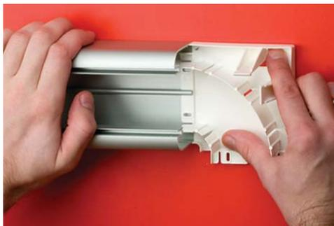
Установите короб на стене. Для этого просверлите отверстия на дне короба. В качестве крепежа рекомендуем использовать на выбор: код ДКС 06541, 06542, 06551 или 06552 (система "M5 Combitech").
