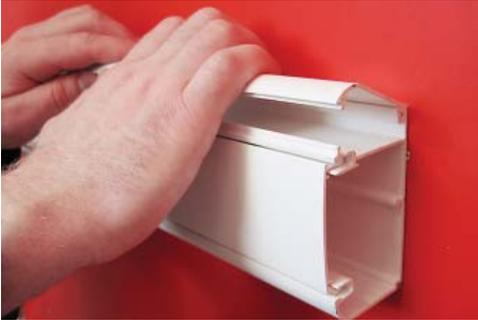
В двухсекционный короб 90/2x50 мм (код 09500) верхняя крышка сначала устанавливается в дальний паз короба (у стены; см. фото), а затем - во фронтальный паз
