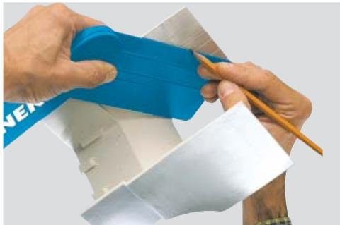
При углах больших или меньших, чем 90°, намечается линия отреза на обоих элементах, лишнее отрезается и угол адаптируется
