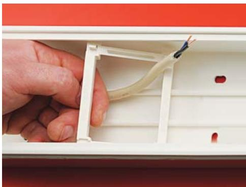
Разместите внутри короба фиксатор рамки (защелками наружу) и пропустите кабель сквозь фиксатор
