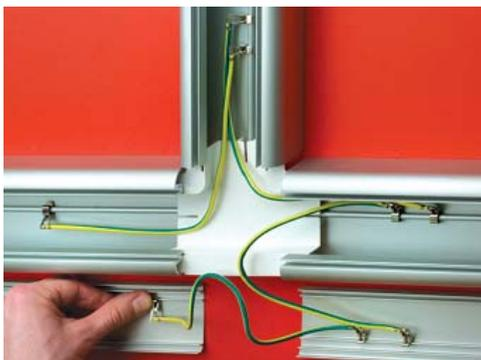
Проводом (код E0001BC) соедините основание одного из коробов с его крышкой. Рекомендуем устанавливать клемму провода (код E0001BC) на дно короба на расстоянии 16 см от клеммы провода (код E0001B). Вторая клемма провода (код E0001BC) защелкивается на направляющую внутри крышки. Проводом (E0001C) соедините 2 крышки (этого и противоположного короба).
