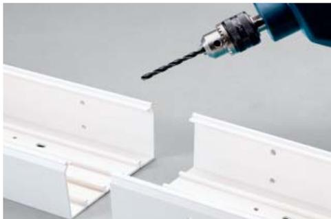
Для определения точек крепления соединителя GTA-SN используйте разметку на самом разделителе. По карандашным отметкам на коробе дрелью просверлите отверстия, используя сверло диаметром 6,5 мм
