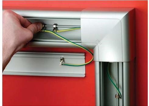
Проводом (код E0001BC) соедините основание одного из коробов с его крышкой. Одна из клемм защелкивается на направляющую, расположенную на дне короба. Рекомендуем устанавливать эту клемму на расстоянии 16 см от клеммы провода (код E0001B). Вторая клемма провода (код E0001BC) защелкивается на направляющую на внутренней стороне крышки.
