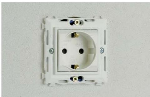
Установите собранное изделие с помощью винтов - в коробки с винтовым креплением, с помощью стальных распорных лапок - в нестандартные коробки или коробки без винтового крепления.
