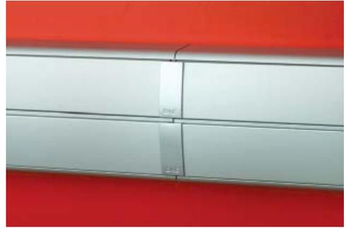
Сдвиньте крышки коробов друг к другу, чтобы они зашли под фронтальные накладки на стык. На длинных, а также вертикальных участках ставьте накладки на стык вплотную к крышкам (без зазора в 3 см).
