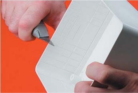
Вырежьте в крышке коробки по перфорации проемы под соответствующий размер канала
