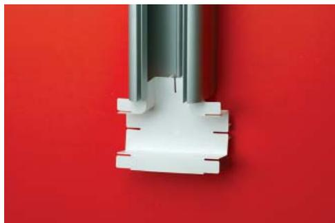
Просверлите отверстия на дне короба. Установите его на стене. В качестве крепежа рекомендуем использовать на выбор: код 06541, 06542, 06551 или 06552. Вставьте в короб базу тройника.
