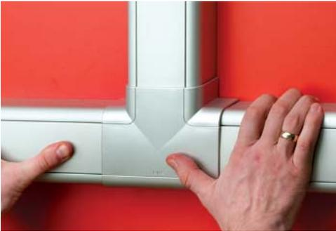
Защёлкиванием установите декоративную накладку на тройник (отвод).
