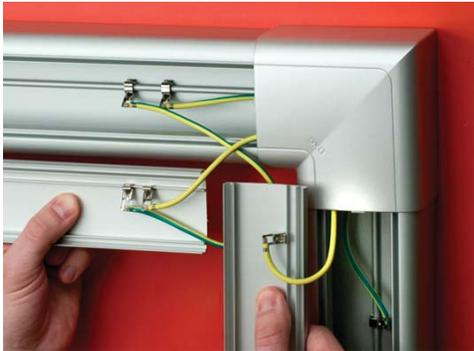
Проводом заземления (код E0001C) соедините крышки коробов. Защёлкиванием установите клеммы на специальные направляющие, расположенные на внутренних сторонах крышек.
