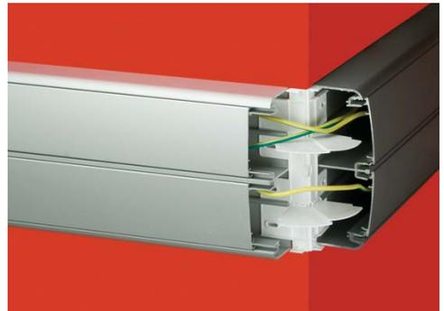
Защелкиванием установите крышки на основания коробов, отступив от края (торца) каждого короба 3 см.
