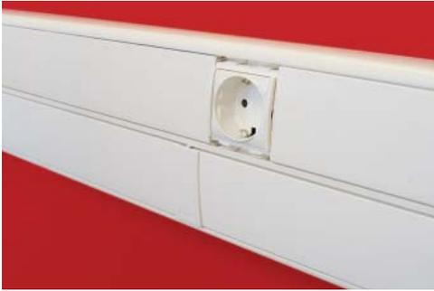
Установите крышки короба рядом с каркасом, оставив зазоры по 3 мм с каждой стороны
