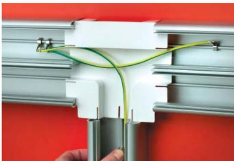
Просверлите отверстия под крепёж на дне третьего короба. Вставив его в базу тройника, закрепите на стене.
