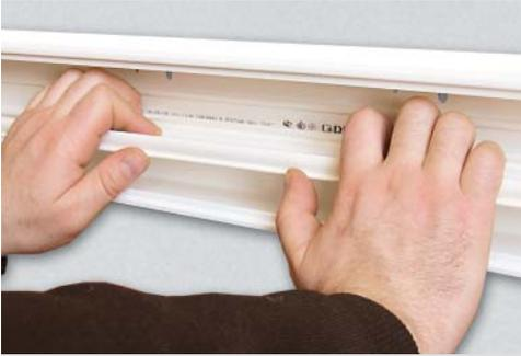
Разделитель устанавливается защелкиванием на направляющие дна короба
