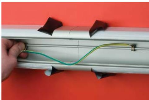
Установите короба на стене. Для этого просверлите отверстия на дне коробов. В качестве крепежа рекомендуем использовать на выбор: код ДКС 06541, 06542, 06551 или 06552 (система "M5 Combitech"). Рекомендуем не снимать полностью защитную плёнку до завершения всех работ.
