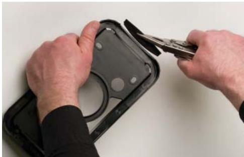
Для ввода напольного кабель-канала в башенку нужно вырезать отверстие под короб в основании башенки (преперфорация есть с 4-х сторон) и подрезать боковые уплотнители у короба
