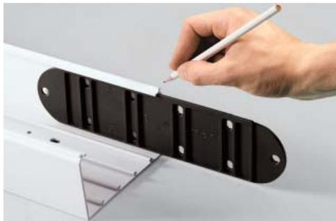
При монтаже коробов "In-Liner", "In-Liner FRONT" на консолях или в подвешенном положении, а также при монтаже коробов "In-Liner FRONT" на стене необходимо закрепить соединитель GTA-SN винтами (идут в комплекте с соединителем)
