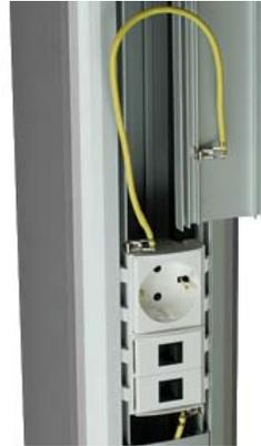
Клемму провода E0001C установите защелкиванием на профиль замка колонны вплотную к каркасам электроустановочных изделий (посадите её как можно глубже). Вторую клемму провода E0001C установите на направляющую на внутренней стороне крышки. Аналогично заземлите проводами E0001C все крышки.
