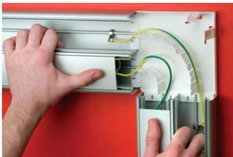
Защелкиванием установите крышки на основания коробов, отступив от края (торца) каждого короба 3 см.
