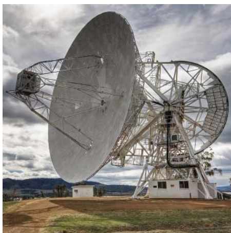
Системы управления и телекоммуникации
