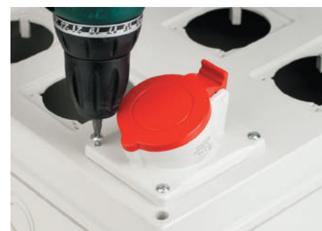
Монтаж розетки на 32 А
