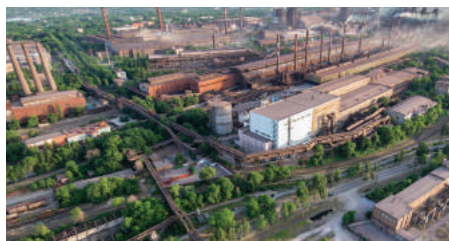
«Запорозжсталь», г. Запорожье
