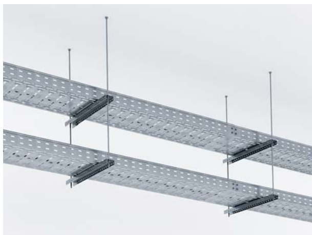
Крепление лотков на двух шпильках и профиле
