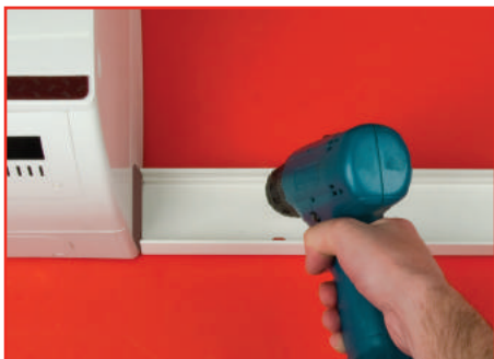
Закрепите основание короба на стене
