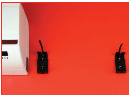
Закрепите универсальные держатели вдоль одной линии (для разметки линии можно использовать крышку короба)
