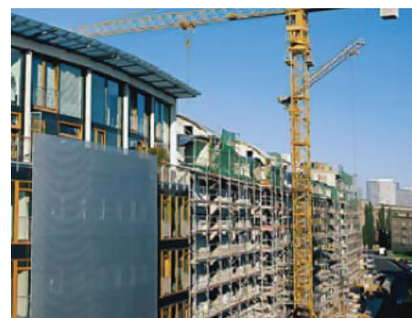
Строительство крупных торговых и складских комплексов
