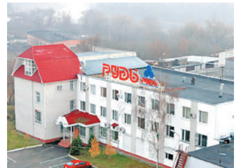
Холодильная станция «Рудь», ПАО «Житомирский маслозавод», г. Житомир
